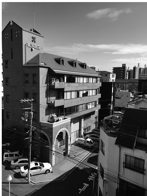
株式会社東洋高压の社屋。閑静な住宅街を望む
